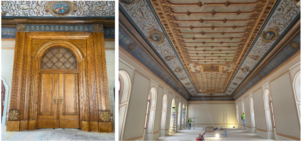
Sultanahmet Yerleşkesi Rektörlük Bina Restorasyonu
