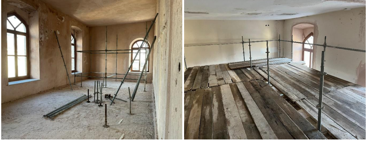
Sultanahmet Yerleşkesi Rektörlük Bina Restorasyonu
